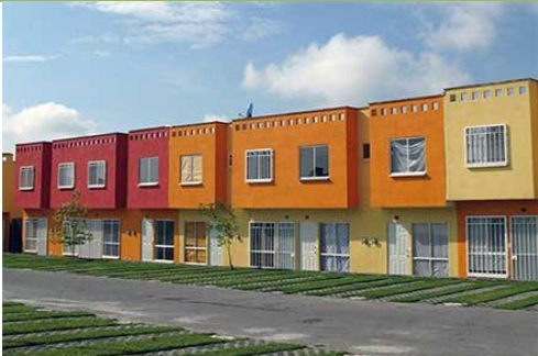
Construcción de viviendas en ciudades emergente
